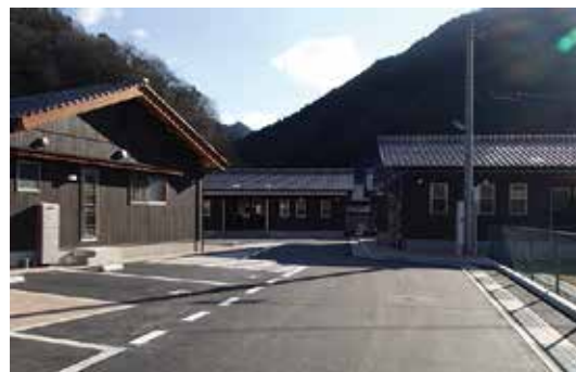
とびのこ山団地第2期建築工事
