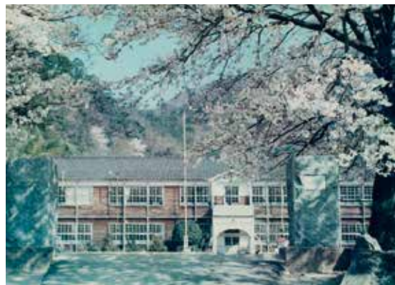
写真①(旧六日市小学校校舎)
