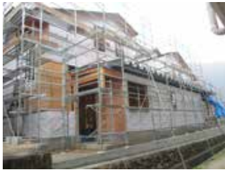
交流センター建設の様子
