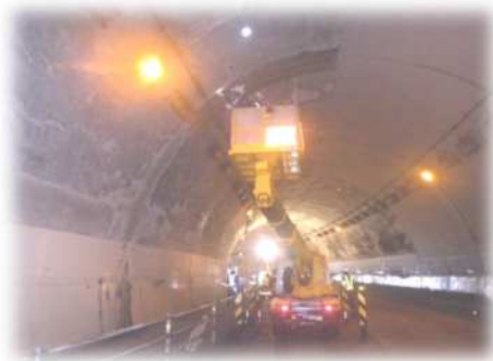
写真 3-1 FRP ネット設置状況
