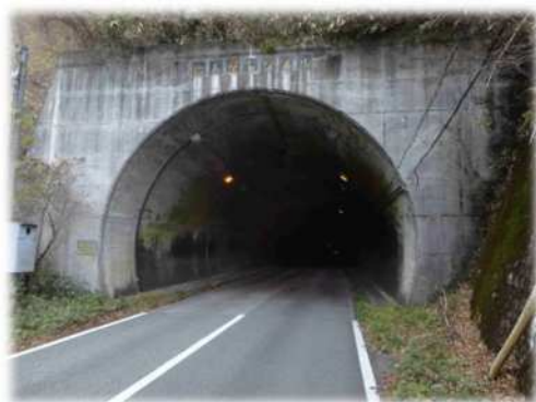
唐人屋トンネル
