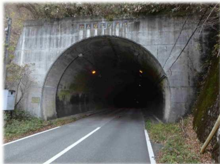
唐人屋トンネル
