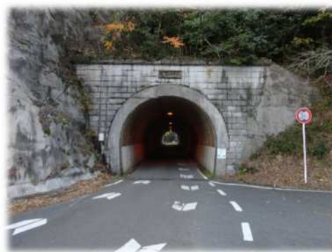
塔ノ峠トンネル
