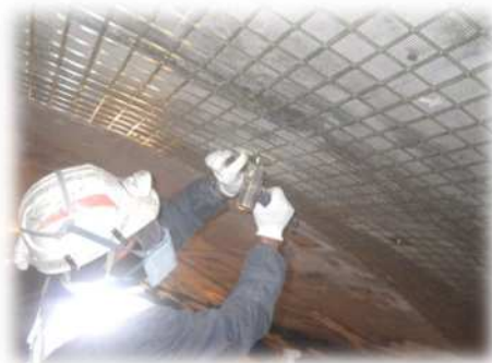
写真 3-1 FRP ネット設置状況
