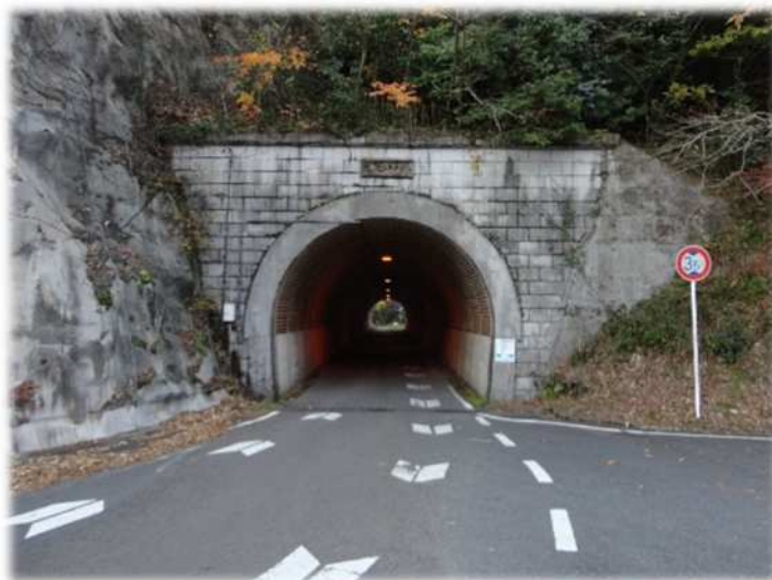
塔ノ峠トンネル
