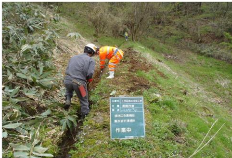
清掃作業の様子
