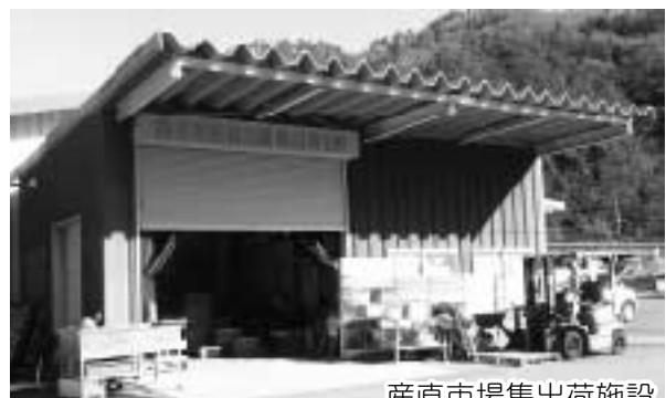
産直市場集出荷施設
