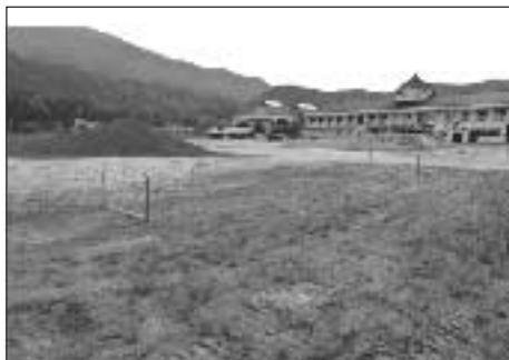
工事が進む真田グラウンド
