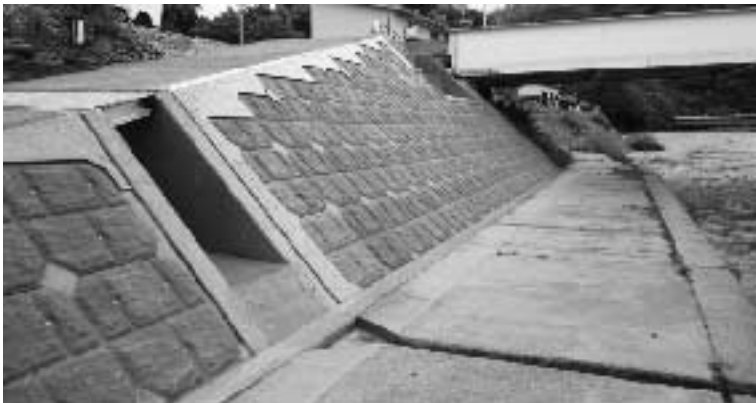
柿木相生橋側道橋架設工事
