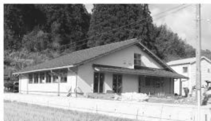
完成間近の朝倉公民館
