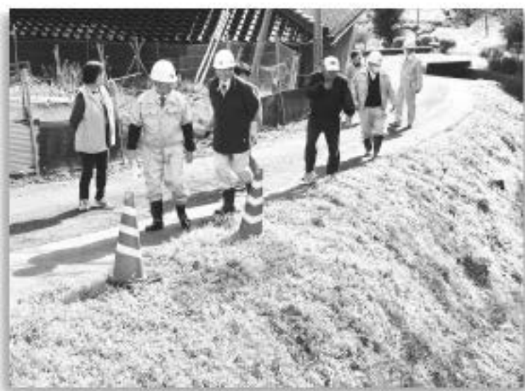
町道二ノ宮線及び林谷川の現地調査
