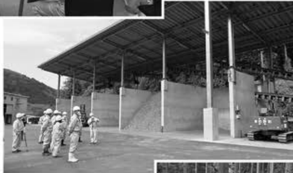
原木・チップヤード施設
