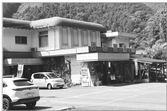
はとの湯荘屋上防水工事費 347万円
