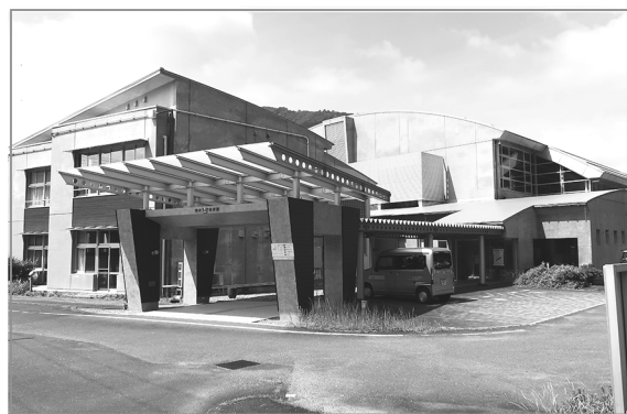
町民柿木体育館修繕費 44万円
