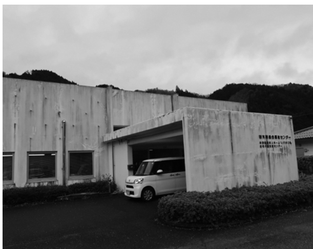
「とびのこ苑」 照明器具 LED 化設備工事 1,421 万 2 千円
