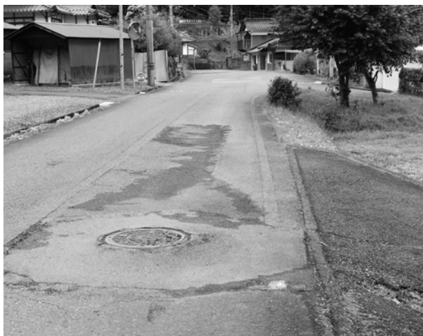
町道沢田線改修工事ほか7路線 5,463万円
