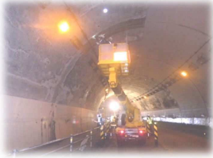
写真 3-1 FRP ネット設置状況
