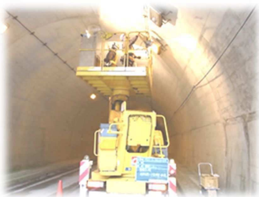
写真 2-1 トンネル点検状況
