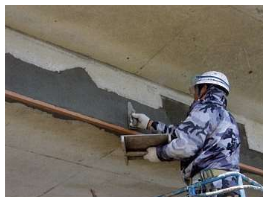
写真 4－3 断面修復状況
