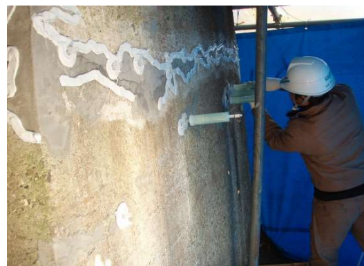
写真 4－2 ひび割れ注入状況
