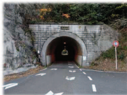
塔ノ峠トンネル
