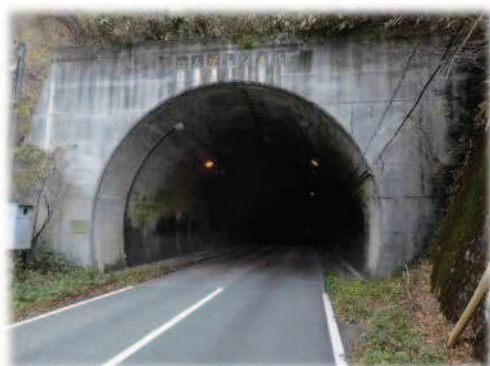
唐人屋トンネル
