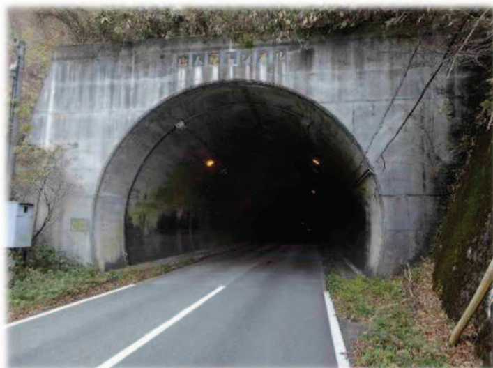
唐人屋トンネル
