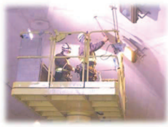
写真 2-1 トンネル点検状況
