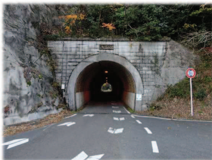
塔ノ峠トンネル
