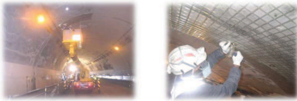
写真 3-1 FRP ネット設置状況
