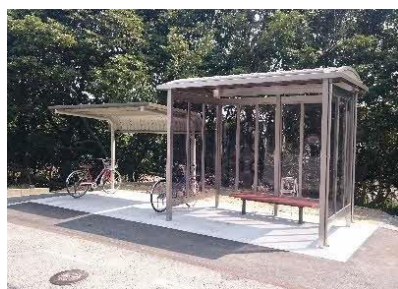
図表-83 停留所に併設した駐輪場(岡山県瀬戸内市)
